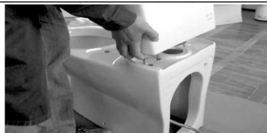
4. Paigaldage WC-poti veemahuti WC-poti tagaküljele.
